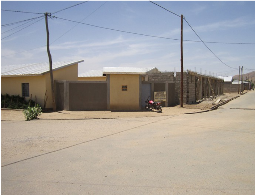
Das Erdgeschoss des Hauptgebäudes ist fast fertig gemauert.
