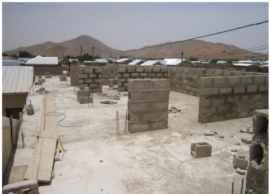
Die Decke ist betoniert und das Mauerwerk im Obergeschoss wächst.
